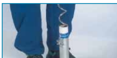
4. Mischen des Fugendichtstoffes
