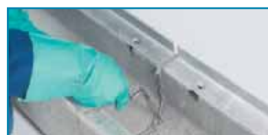
6. Glätten der Fugenoberfläche
