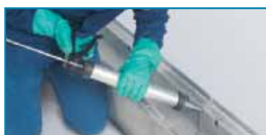
5. Einbringen des Fugendichtstoffes
