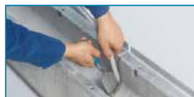
3. Einbringen der PE-Dichtschnur
